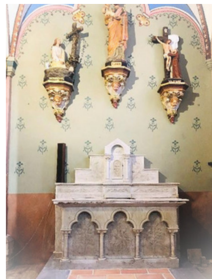
Restauration de l'Autel Saint Joseph
