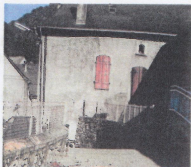
Réhabilitation appartement instituteur
